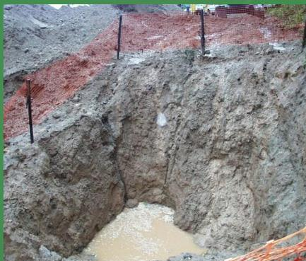
Os materiais retirados da escavação devem ser depositados a uma distância superior à metade da profundidade da mesma ou 2m (dois metros), a maior das duas, medida a partir da borda do talude. Cuidado especial deve ser dispensado aos materiais que possam rolar para o interior da escavação, devendo ser retirados ou escorados, de modo a evitar acidentes
